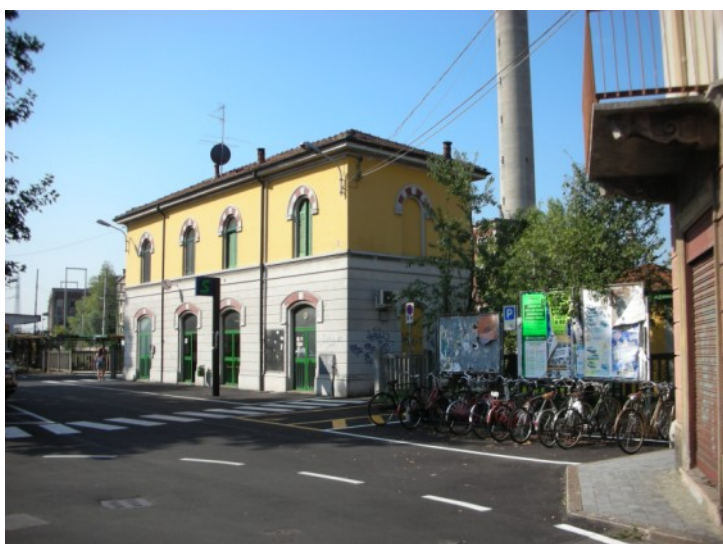
Vista attuale della stazione di Varedo
