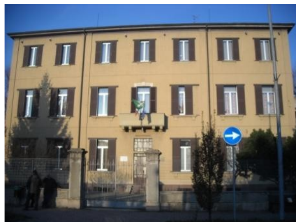
Vista attuale delle scuole elementari
