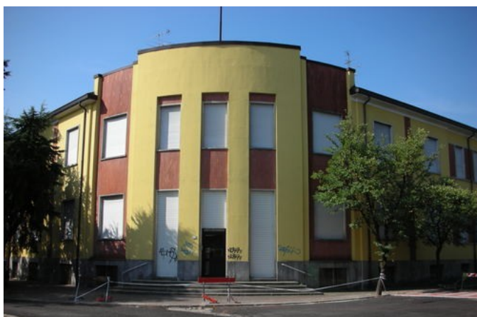
Vista attuale delle scuole elementari
