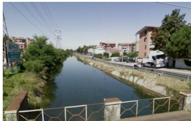
Vista attuale del Canale Villoresi
